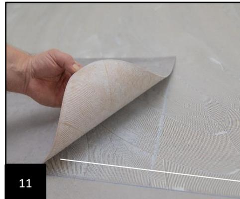
Marque ahora el elemento a colocar (12) y córtelo con las medidas exactas de modo que no cubra la junta del margen (13), a fin de evitar los puentes acústicos y deformaciones por recalado en las paredes y los marcos de las puertas.
